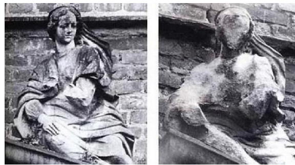
图1 酸雨腐蚀建筑物
