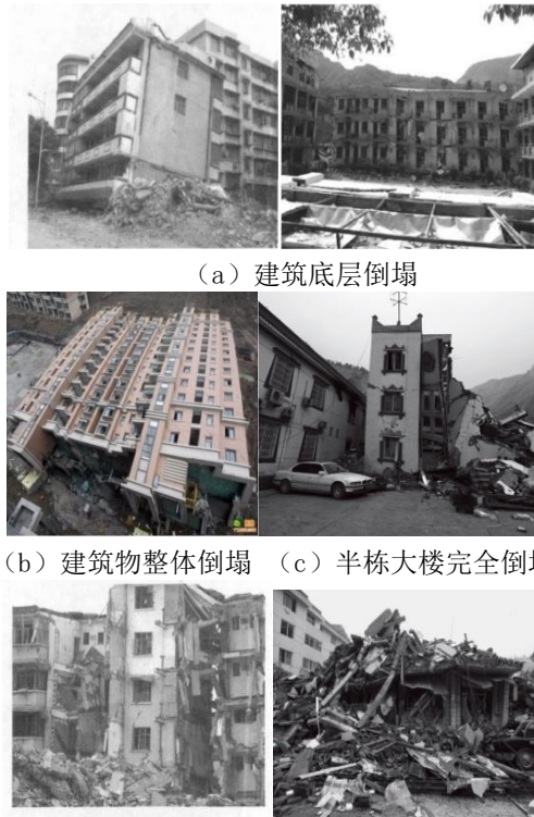
(a) 建筑底层倒塌 (b) 建筑物整体倒塌 (c) 半栋大楼完全倒塌
