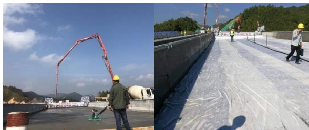
图2 桥面铺装施工
