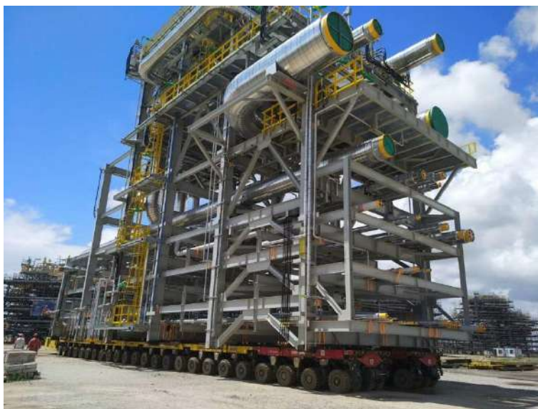
图 1 成型封装的集成模块运输装船
