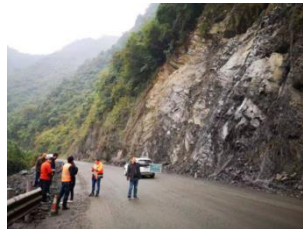
图9 石质上边坡垮塌
