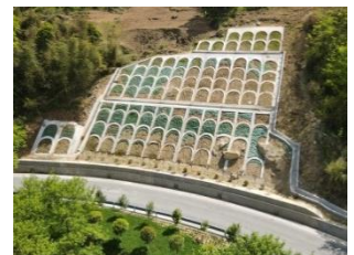
图6 施工完成后实拍
