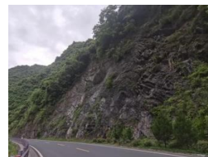
图10 施工完成后实拍
