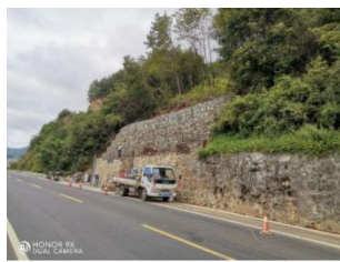
图8 施工完成后实拍
