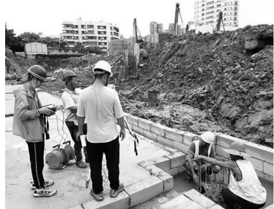
图 1 超声波法现场检测
