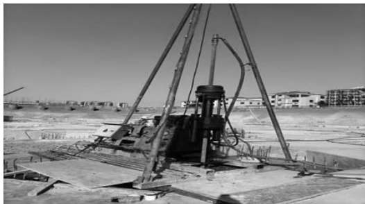
图2 钻心法现场检测
