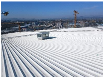
图8 杭州西站金属屋面完成图
