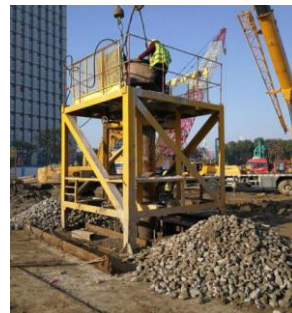
图2 混凝土浇筑作业准备
