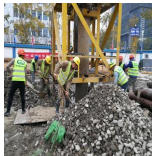
图1 反压碎石填筑作业
