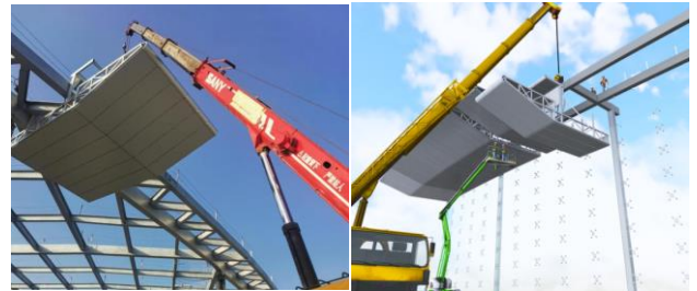
图11 檐口模块整体吊装示意图
