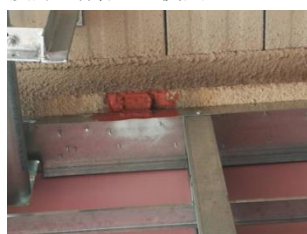
图5 角码与钢结构连接
