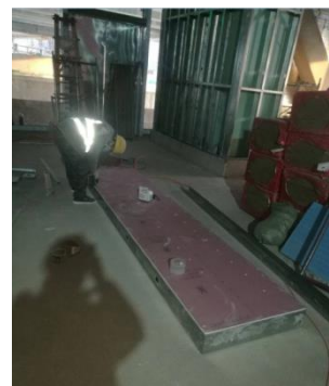
图 17 预拼装隔墙安装
