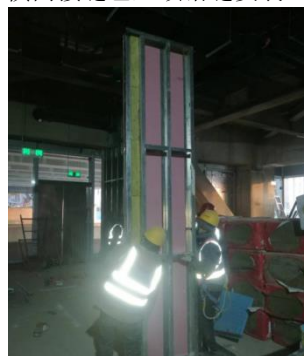
图 16 轻钢龙骨隔墙预拼装
