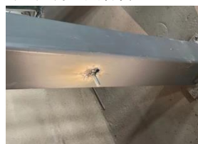
图 15 轻钢龙骨通过螺柱与钢结构连接
