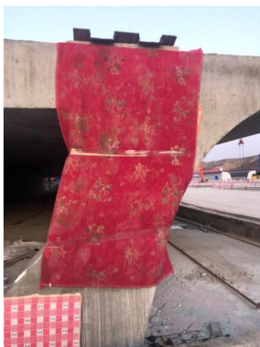
图8 预制梁体封锚电热毯覆盖养护
