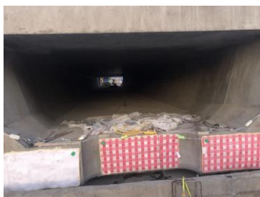
图9 预制梁体封锚电热毯覆盖养护
