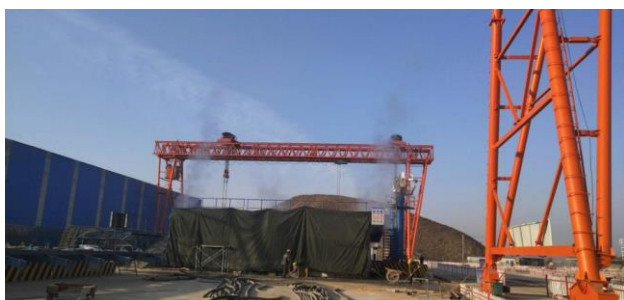
图 5 制梁区端头覆盖养护
