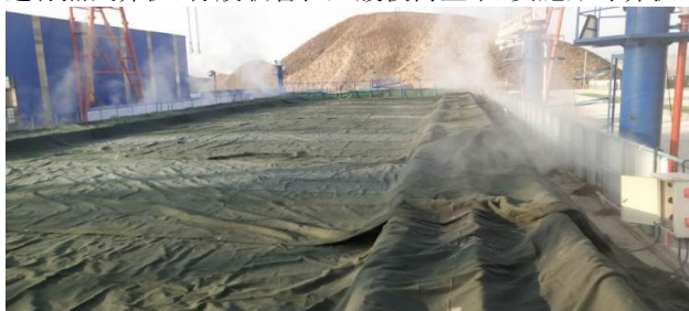
图 4 制梁区顶板养护
