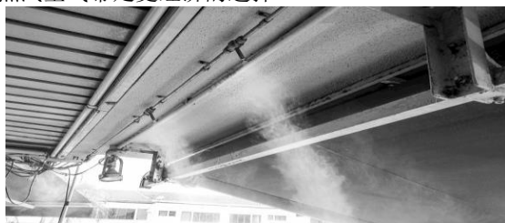
图1 蒸汽空气幕
