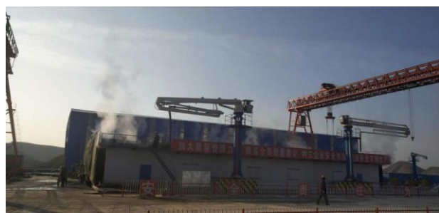
图 6 制梁区腹板保温板养护
