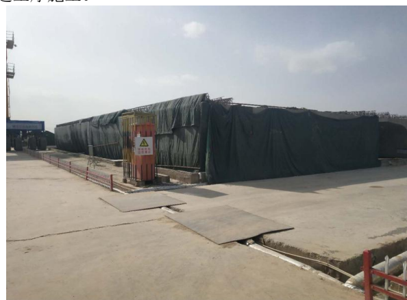
图 7 存梁区梁体压浆侧面和端头覆盖养护
