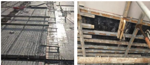
图 5 现场加固照片
