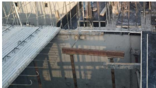
图 4 模板支设完粘贴海绵条
