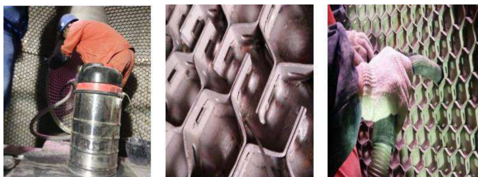
图3 喷砂作业图
