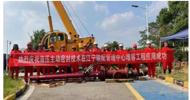
图5 输气管道带压主动密封封堵技术施工
