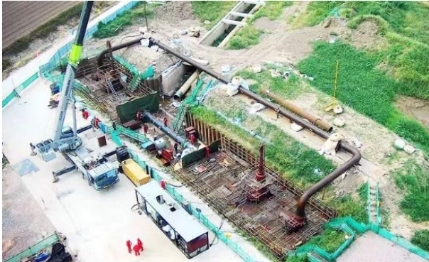
图4 输气管道不停输改造施工现场
