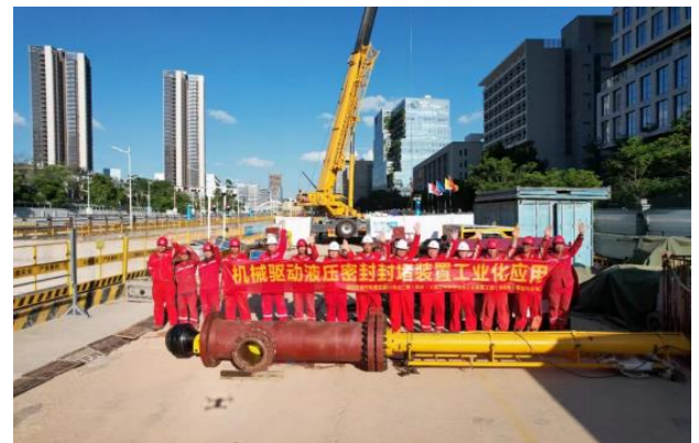
图6 输油管道带压液压主动封堵技术施工
