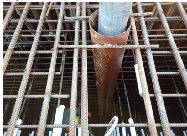
图3 高支模混凝土浇筑
