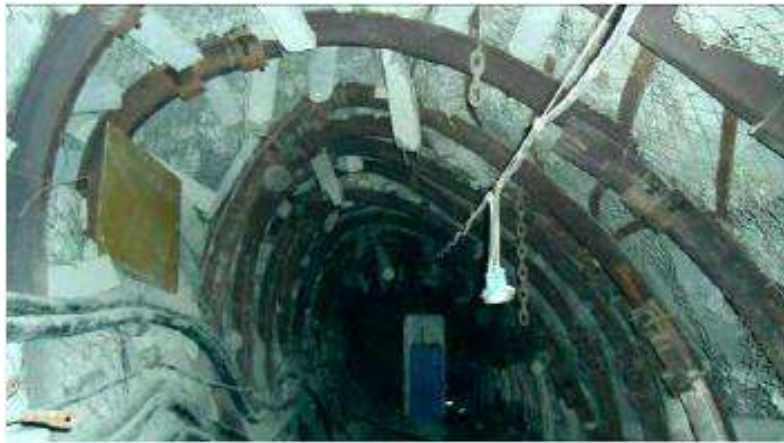
图2 巷道围岩变形剧烈
