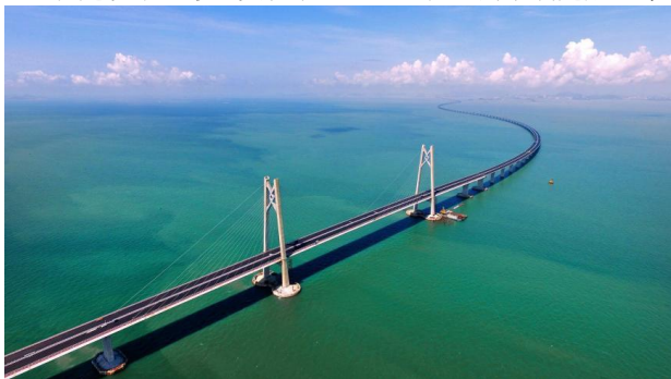
图 1 港珠澳大桥海上桥梁施工
