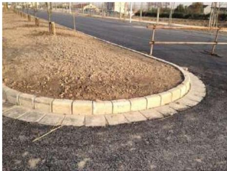
图8 圆弧顶侧平石常规布设
