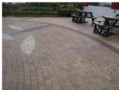
图5 采用顺圆弧方向铺设道板砖或料石
