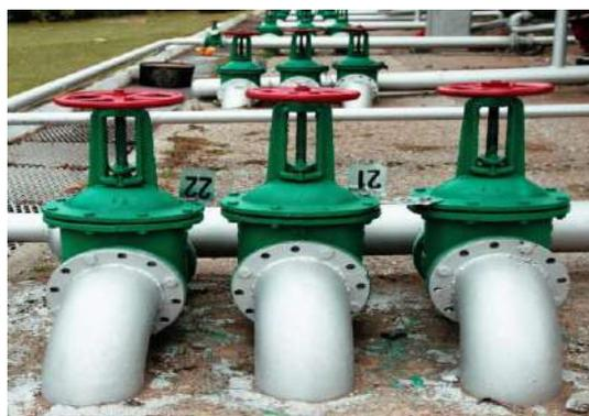
图 2 石油输送管道阀门装置
