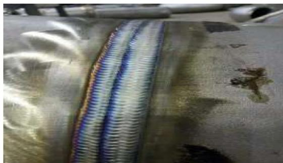
图 1 钨极氩弧焊施工效果图
