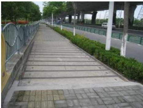
图10 桥头电力工井盖板对盲道的阻断
