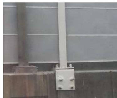
图3 骑马铁上安装H型钢立柱
