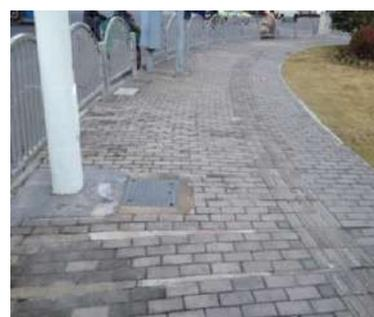
图4 路口转弯道板砖上的斜三角水泥缝
