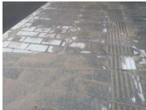
图11 不锈钢井框取代电力工井盖板
