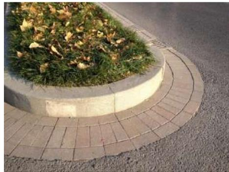
图9 圆弧顶侧平石单独设计精心施工
