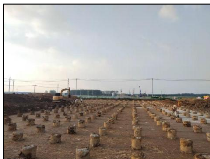
图7 全螺紋桩身施工验证施工效果
