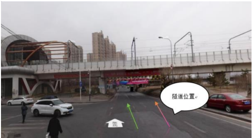
图 1 隧道开挖实际现场图
