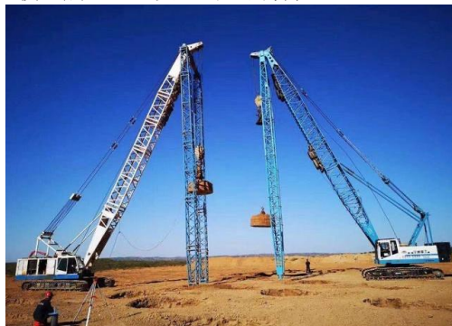
图1 为强夯法施工技术应用现场
