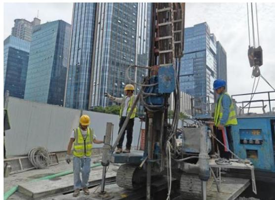
图 9 钻机引孔
