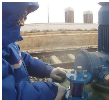
图 10 安装液压油箱盖
