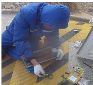
图 9 安装密封条
