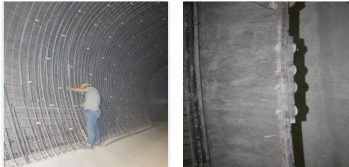
图4 纵向水平筋安装卡具图
