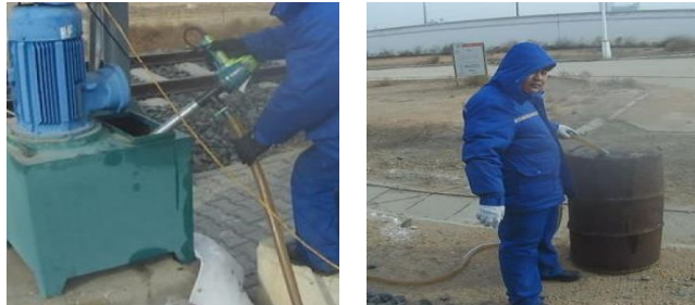
图 2 更换液压油过程
