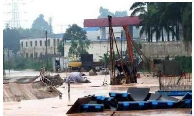
图1 暴雨天气下的施工环境
