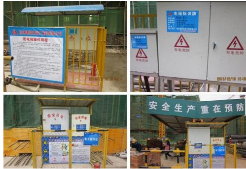
图2 施工临时用电安全防护现场图
