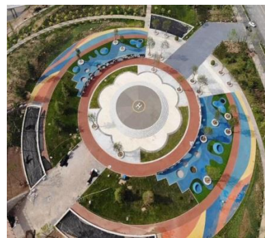
图3 飞行梦工厂(施工中实景照片)
