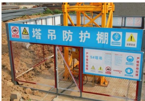
图1 塔吊防护棚
