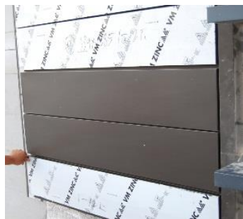
图 6 内锁扣墙面
