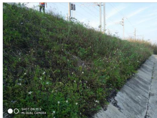
图12 案例三施工后坡面(2)
