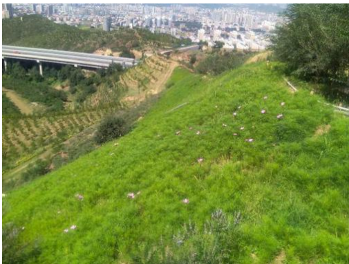
图7 案例二施工后坡面(1)
