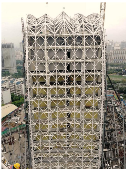
图3 瀑布钢结构安装完成效果
