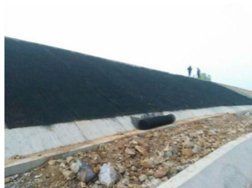
图10 案例三施工中坡面
