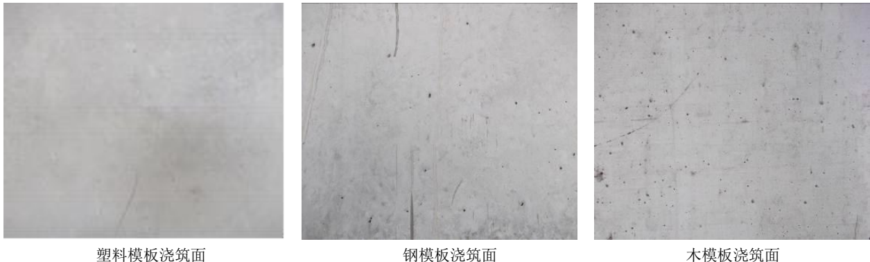
图 5 三种模板浇筑混凝土面对比
