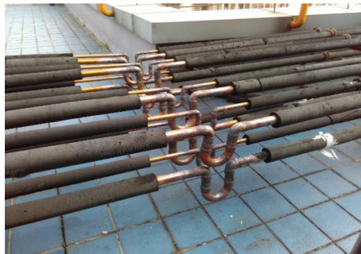
图5 改造后冷媒管路图示
