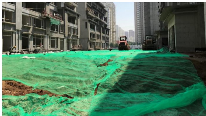
图4 地下室顶板回填土施工
