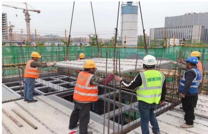
图1 叠合板吊装施工图
