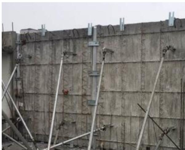
图5 叠合墙板连接示意图
