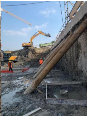
图 6 开挖成型照片
