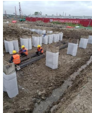
图 2 泡沫塑料包裹隔离
