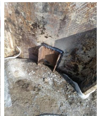
图 3 槽钢卡扣焊接
