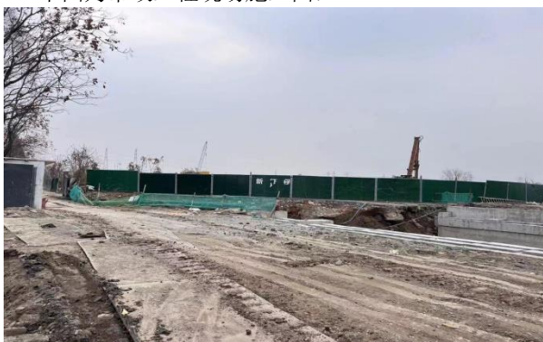
图2 市政工程现场施工图
