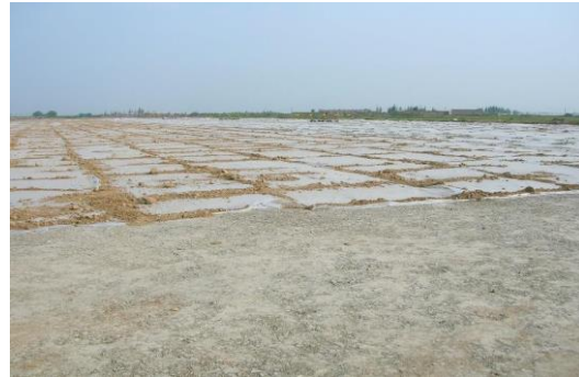
图3 塑料薄膜覆盖养护
