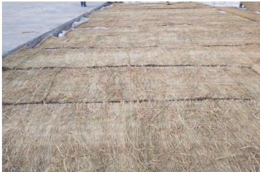
图2 草帘+土工布覆盖养护
