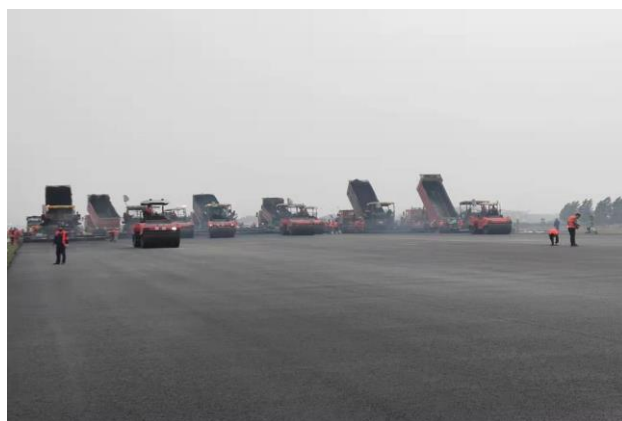
图 1 多台摊铺机连铺作业
