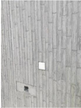
图3 预制混凝土构件设备末端预留孔
