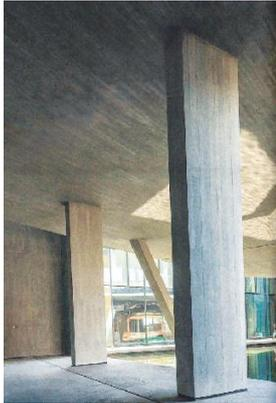
图1 现浇装饰清水混凝土
