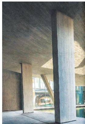
图1 现浇装饰清水混凝土
