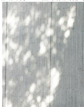
图2 预制装饰清水混凝土
