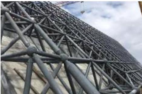
图1 建筑钢网架施工成品
