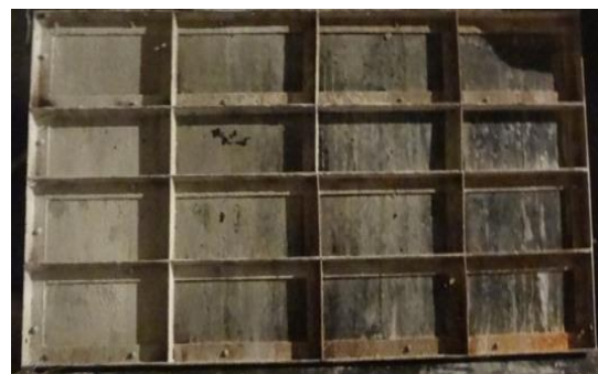
b 侧墙自制模板
