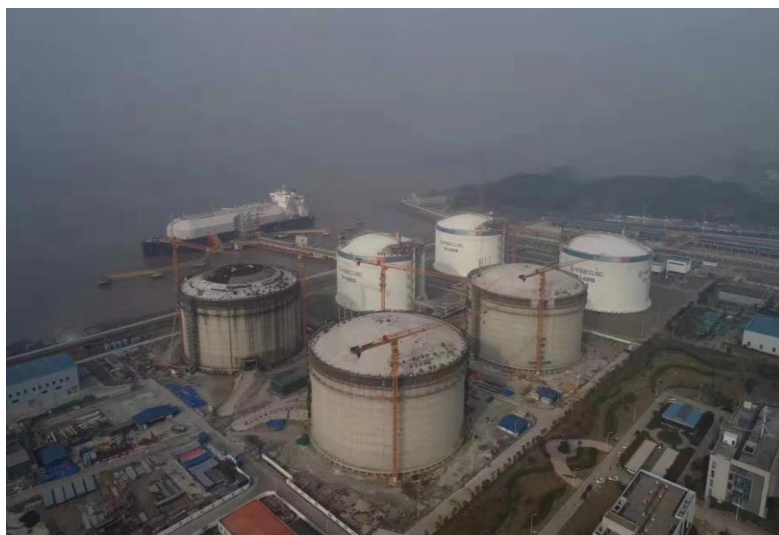
图2 低温储罐外观图
