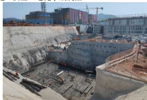
图1 现场基坑情况
