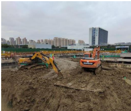
图5 开挖现场影像
