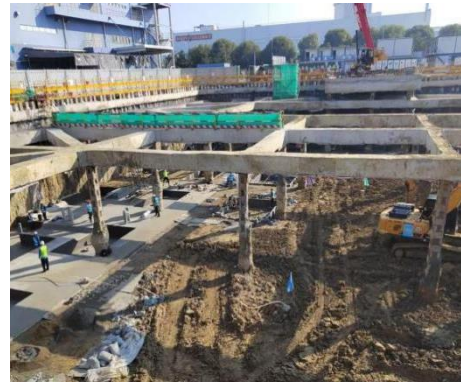
图6 开挖现场影像
