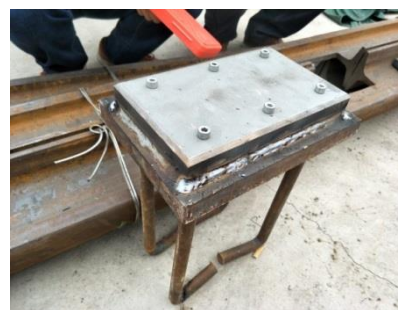
图 4.2.1-1 底座钢板焊接
