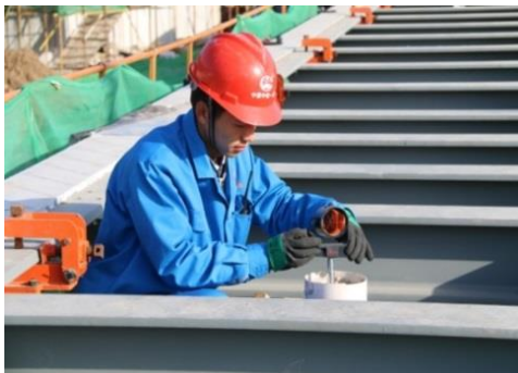
图 4.2.5-1 控制基桩安装棱镜
