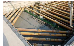
9月21日基坑南侧中板完成
