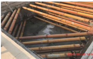
9月8日基坑南侧底板完成
