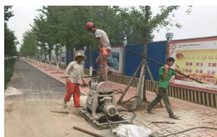
地面深孔注浆
