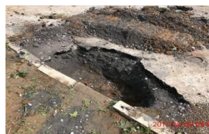
沉陷区域局部挖探
