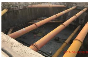
8月30日基坑南侧垫层完成
