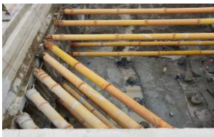
8月31日基坑南侧增设斜撑
