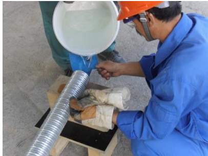
图2 波纹管检漏试验
