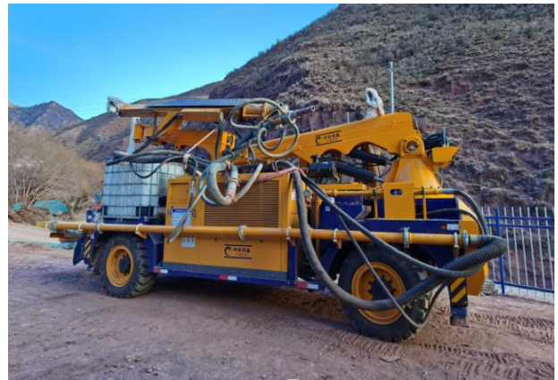
图3 HP3017G 湿喷机械手施工
