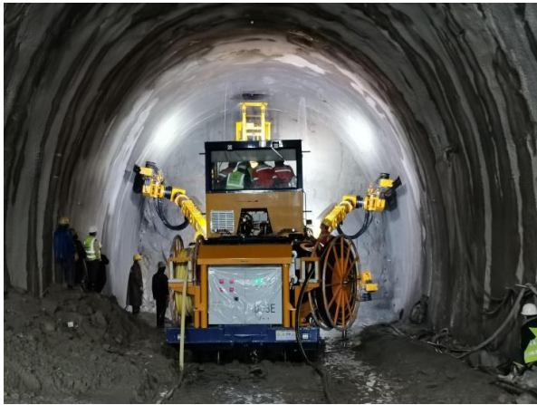
图2 DJ3E 凿岩台车施工现场
