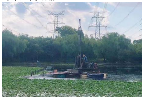
图 2 水上作业施工
