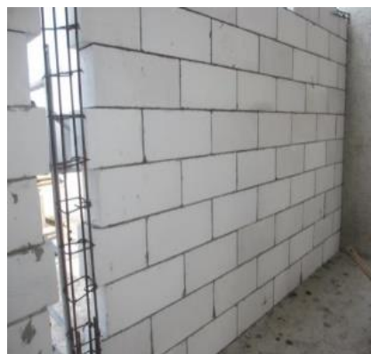
图 4 AAC 保温砌块施工应用
