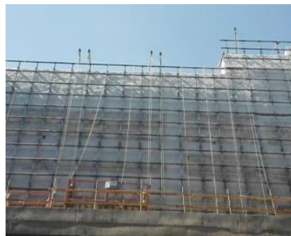
图 5 梁、柱混凝土面层超细无机纤维施工
