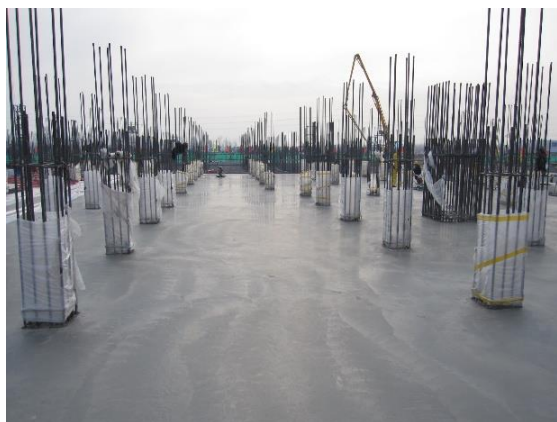
图 6 钢筋保护包裹图
