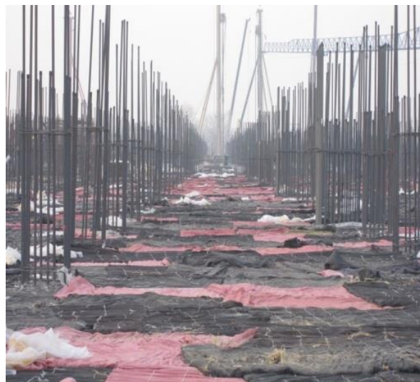
图 5 冬施混凝土养护图
