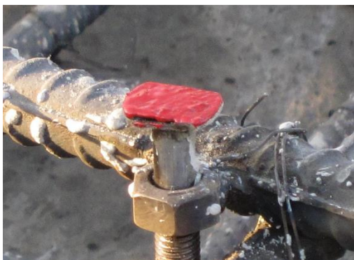
图2 底板的标高控制实体效果图
