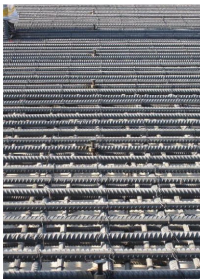
图4 底板标高及平整度的控制装置布置图
