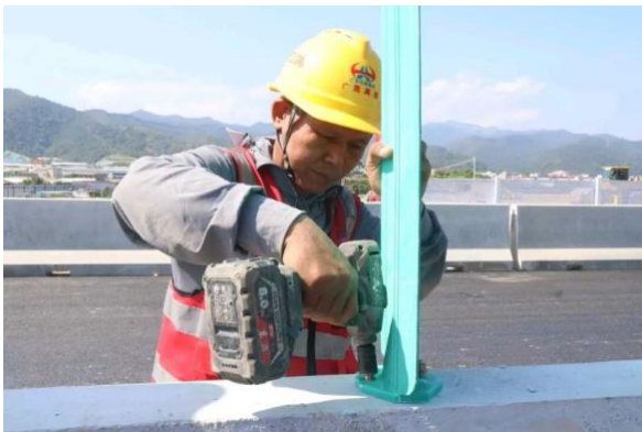
图2 安装防眩板
