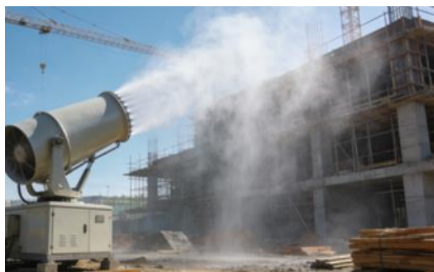
图2 喷雾抑尘设备作业现场图
