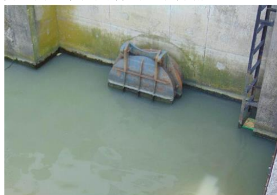
图 1 拍门锈蚀
