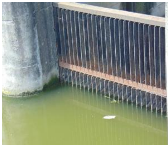
图 2 拦污栅锈蚀
