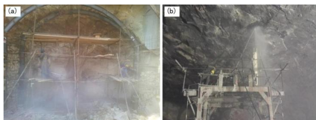
图2 初期支护施工：(a) 钢拱架安装；(b) 锚杆施工
