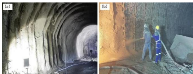
图4 封闭与固结施工：(a) 喷锚施工；(b) 回填灌浆
