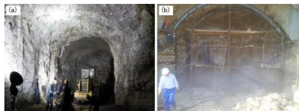
图3 空腔回填施工：(a) 钢筋网片安装；(b) 毛石回填
