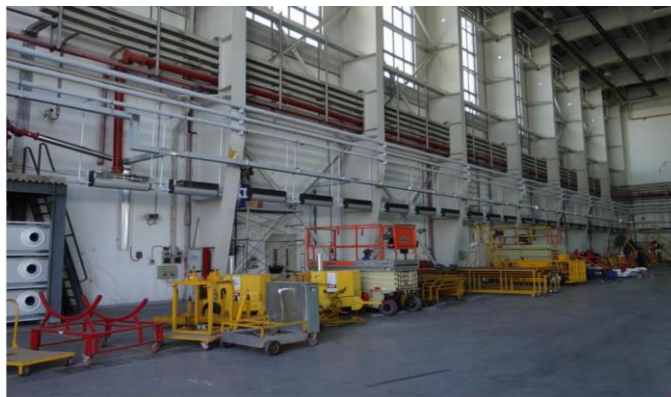
图1 某库房改造后内部情况
