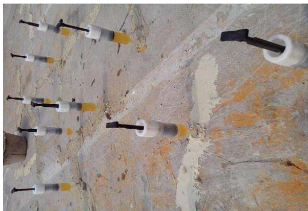
图 2 混凝土结构注浆效果
