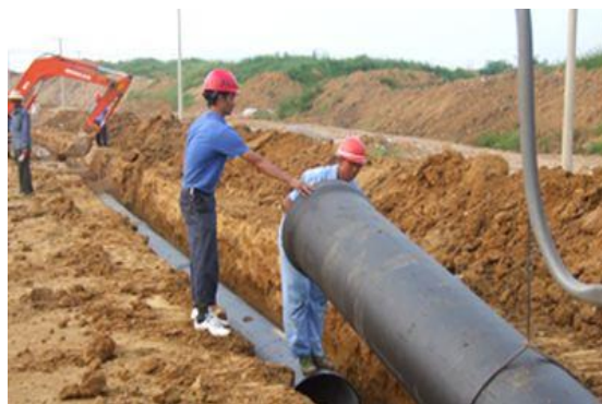
图 2 给排水管道安装
