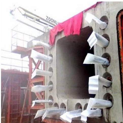
图 1 管道通孔检查
